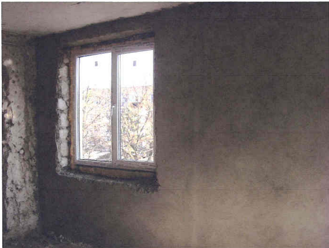
Anexa 9: Golurile de fereastră spre transformare în goluri de ușă/cale de acces pentru comunicare cu ascensorul spre montare.
